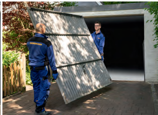
Ausbau und umweltgerechte Entsorgung
